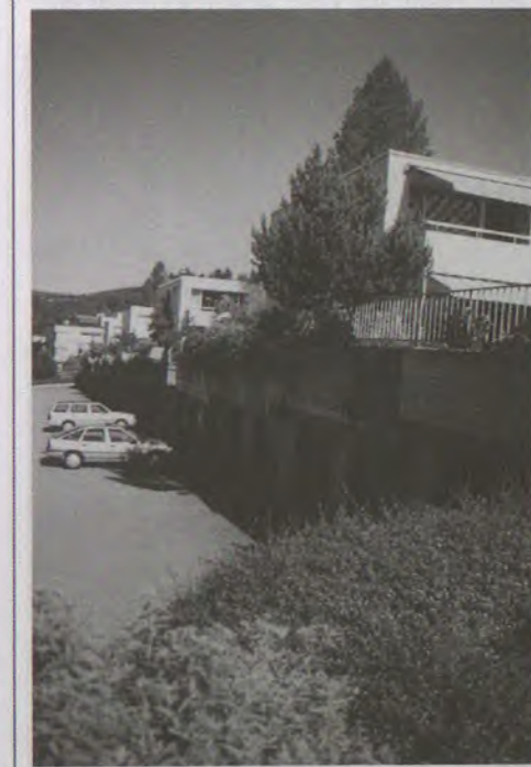
Vor 30 Jahren entstanden: Wohnbaugenossenschaft «Oberhofstetten»
